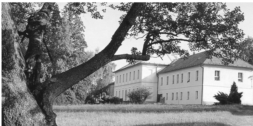
Замок «Бржезина», в котором жил К.М. фон Штернберг после отъезда из Регенсбурга
